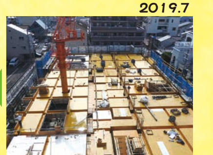
床に鉄板が！建物らしくなってきました
