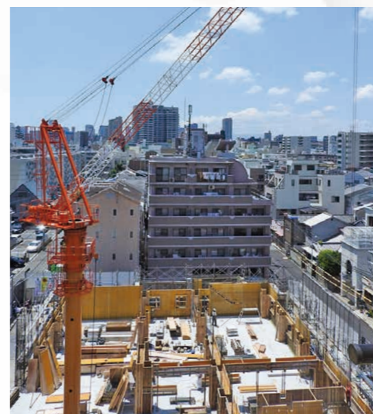
新園舎建替工事の様子
