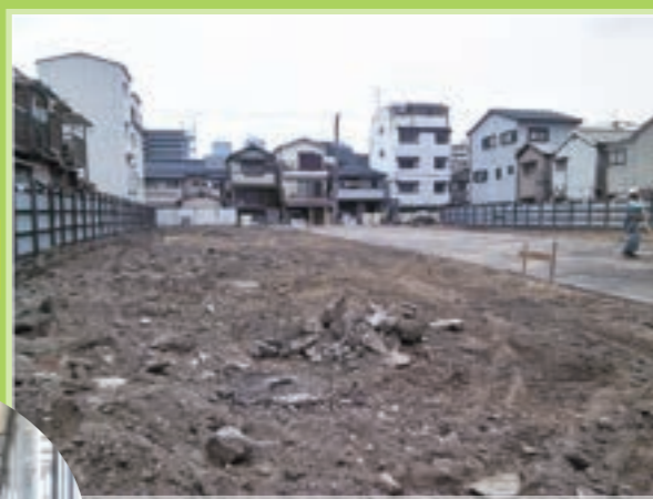
駐車場のアスファルトを掘り起こしました。
